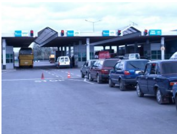
Drogowe przejście graniczne w Dorohusku
