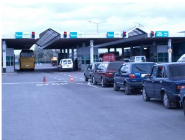
Drogowe przejście graniczne w Dorohusku
