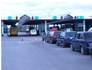
Drogowe przejście graniczne w Dorohusku
