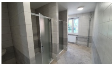
Modernizacja budynku Placówki Straży Granicznej w Kodniu
