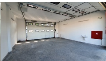
Modernizacja budynku Placówki Straży Granicznej w Kodniu
