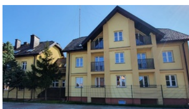
Modernizacja budynku Placówki Straży Granicznej w Kodniu
