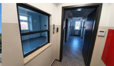
Modernizacja budynku Placówki Straży Granicznej w Kodniu
