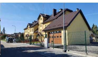
Modernizacja budynku Placówki Straży Granicznej w Kodniu
